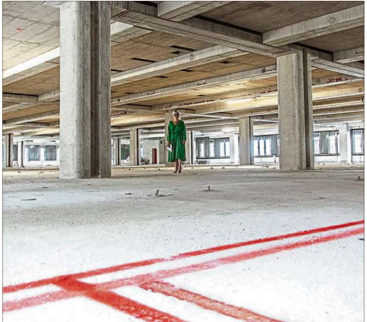
Die Leiterin der Abteilung Bau im Klinikum, Andrea Bugl, steht mitten in den leeren Hallen für den neuen Intensivbereich.
